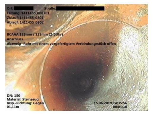
Foto: Video: Zustand: BCA A A Anschluss Abzweig- Rohr mit einem vorgefertigtem Verbindungsstück offen, 2 Uhr, Kamrera lässt sich nicht einsetzten
